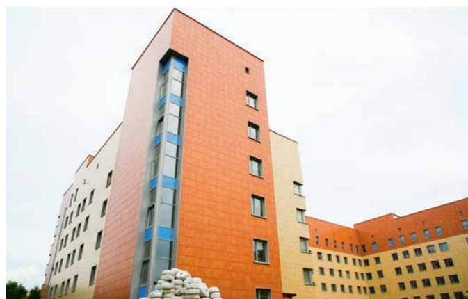
Строящийся корпус горбольницы №33 в Колпинском районе
