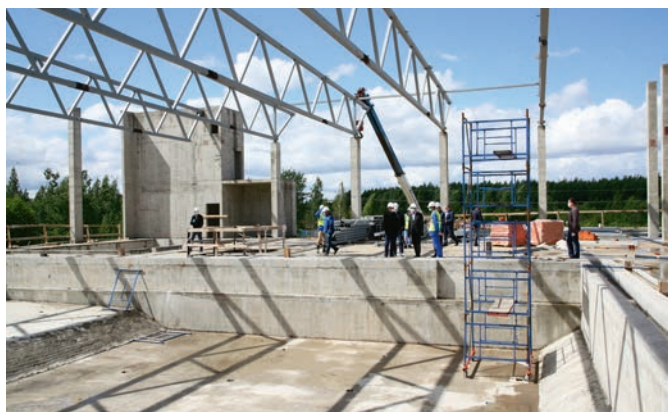
Строительство спортивного комплекса в Петродворцовом районе
